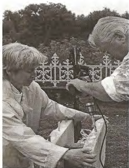
4- La restauration des 10 stèles en marbre du cimetière a été exécutée par un tailleur de pierres d'expérience. L'opération nécessitait l'installation, au cœur du plan de fracture, de goujons filetés en acier inoxydable. Le diamètre et la longueur de ces goujons est fonction de l'épaisseur de la pierre. Une résine époxy était ensuite appliquée sur les goujons et, de façon très ponctuelle au centre du plan de fracture.
