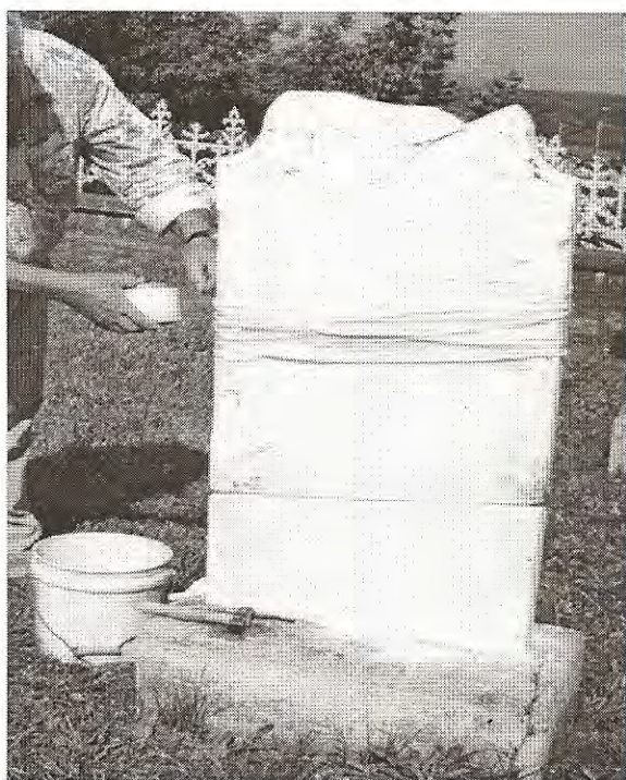
7- Un tissu humide entouré d'une membrane imperméable est appliqué sur le joint nouvellement rempli afin de ralentir la prise du mortier et d'éviter qu'il ne se fendille en séchant.
