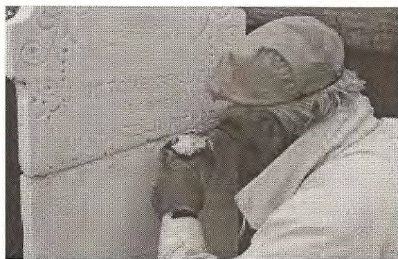
6- L'étape suivante consiste à retenir la fente avec le mortier à base de chaux éteinte et de ciment. L'application s'effectue en évitant tout débordement sur la surface.
